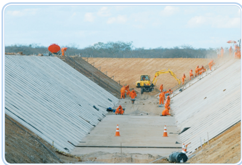
Figura 4.4: Foto da obra de transposição do São Francisco
